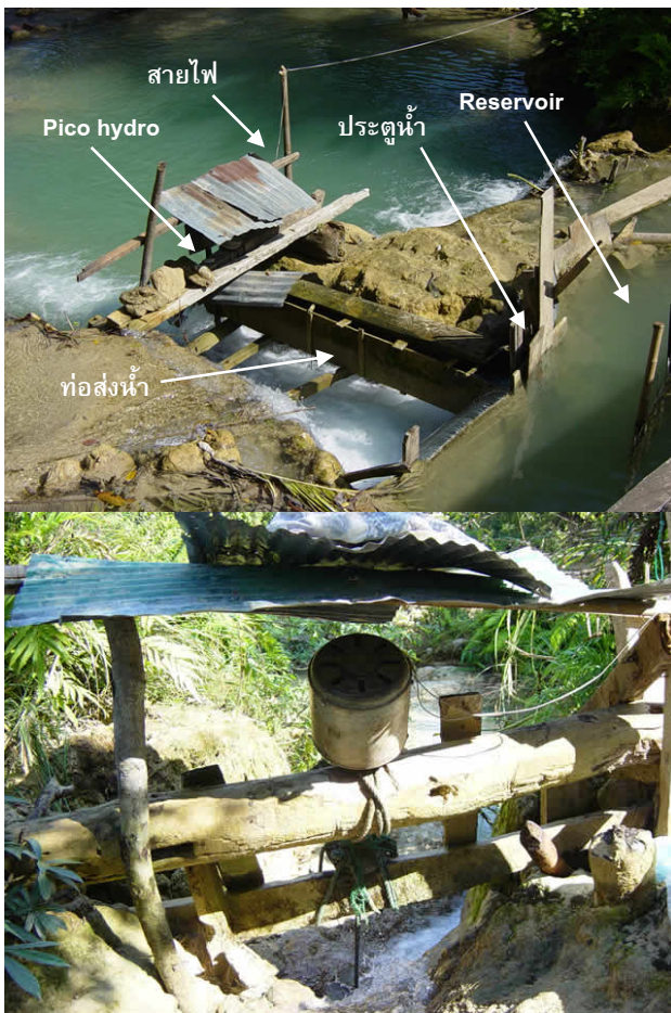
รูปที่ 3 การติดตั้ง Pico hydro อย่างง่ายที่บ้านท่าแปน
