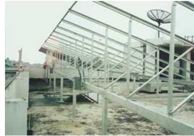
รูปที่ 8 การติดตั้งโครงเหล็กชุบกล้าไนซ์
