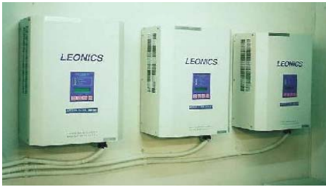
รูปที่ 5 อินเวอร์เตอร์แบบต่อตรงเข้าระบบแบบเฟสเดียว จำนวน 3 เครื่อง
