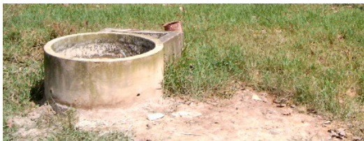
รูปที่ 4 ส่วนบนสุดของบ่อหมักแก๊สชีวภาพแบบฟิชชโคม
