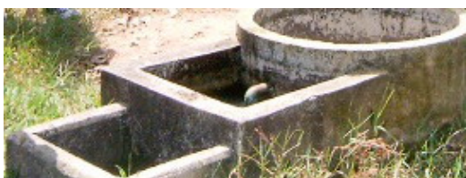
รูปที่ 5 ท่อนำแก๊สจากบ่อหมักแก๊สชีวภาพ
