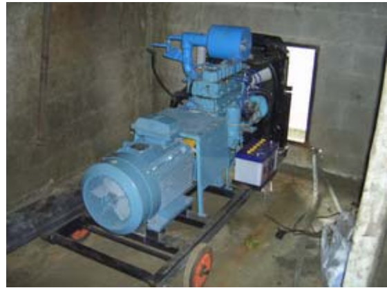
รูปที่ 5 เครื่องกำเนิดไฟฟ้าและเครื่องยนต์ต้นกำลัง
